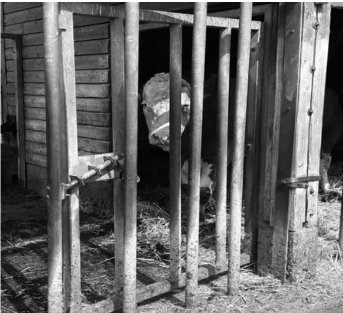
Das Torschloss wird von außen gelöst. Bauartbedingt fällt das Tor von selbst zu und sperrt den Bullen im Stall ein. Der Tierbetreuer kann den Außenbereich der Bullenbucht betreten ohne Gefahr zu laufen, auf den Bullen zu treffen. Öffnet er das Tor, bewegt er sich dahinter und verlässt den Laufhof durch die Gitterstäbe.
