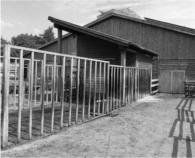
Über den Laufhof haben Kühe und Bullen die Möglichkeit, Kontakt aufzunehmen. Senkrechte Streben bilden eine stabile Einzäunung und ermöglichen dem Tierbetreuer gegebenenfalls die Flucht über die gesamte Länge der Deckbullenbucht.
